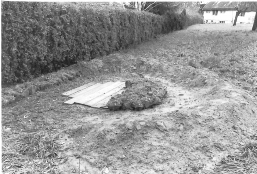
Abb. 31 Die Grubenöffnung ist mit Brettern und zur Hälfte mit Rasen- ziegeln überdeckt; der Damm gegen Oberflächenwasser ist angelegt.
