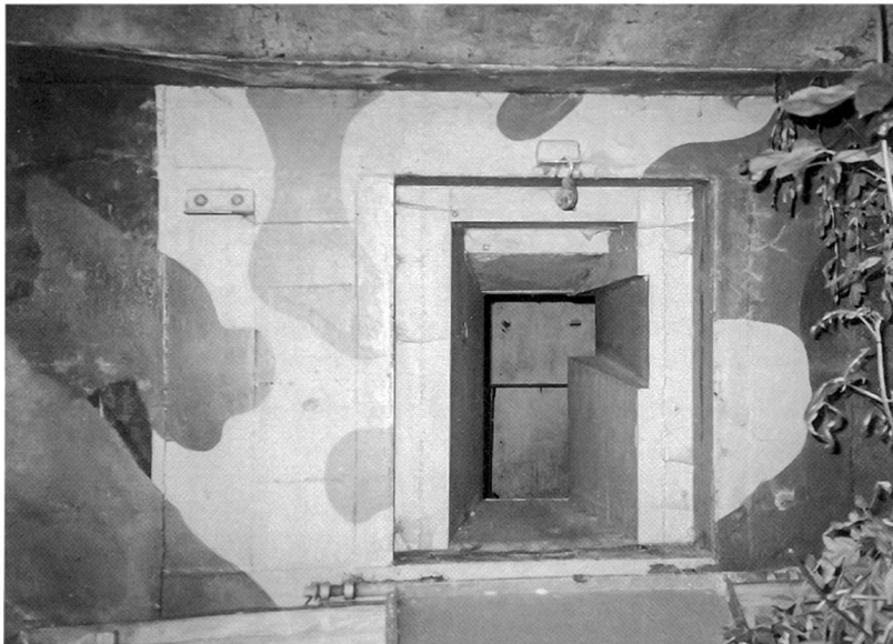
Abb. 11: Artilleriewerk «Obermumpf»: Die auffällige Schiess- scharte, umgebaut für die 7,5-cm- Gebirgskanone. Aufnahme von aussen 1998. (Foto Mike Hess)
