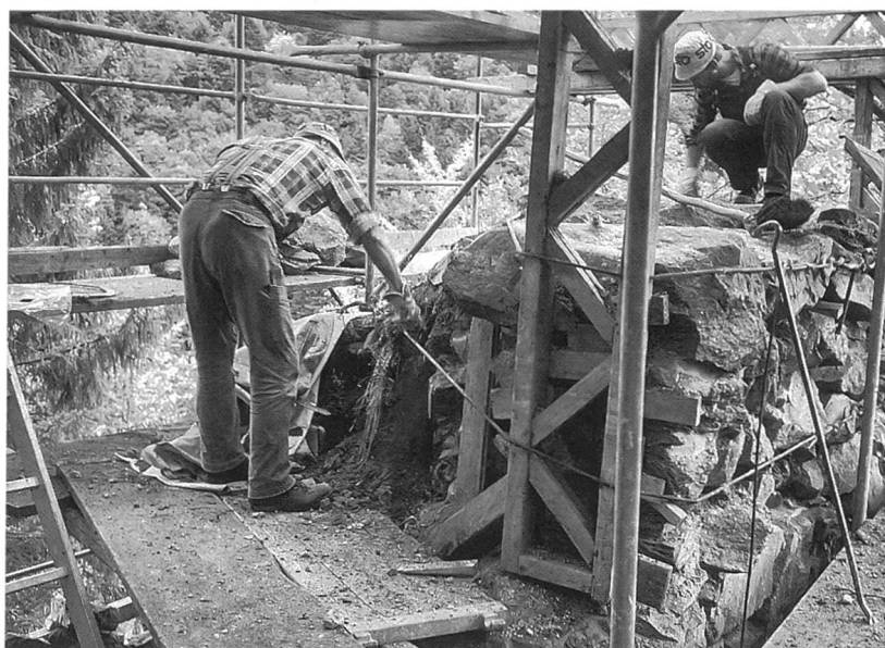
Abb. 6 Wieladingen. Facharbeiter beim Instandsetzen des teilweise schlechten Mauerwerks.
