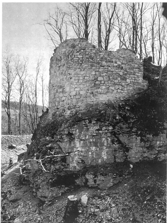
Abb. 3 Der Rundturm über dem äusseren Burggraben.
