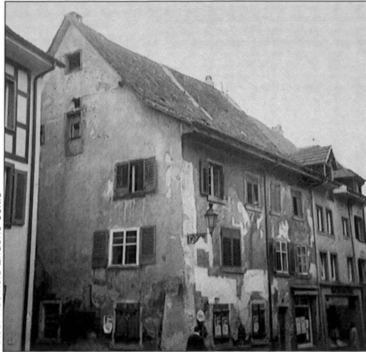
Abb. 1 Bad Säckingen, Haus Rheinbrückstrasse 8 vor dem Abbruch.
