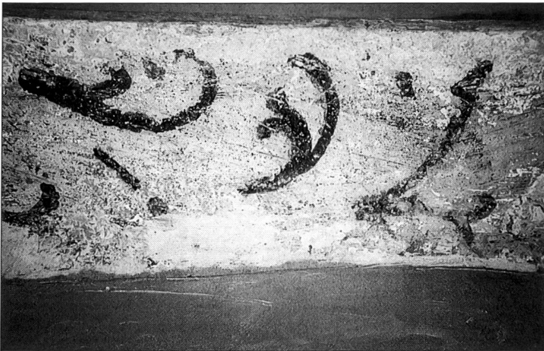
Abb. 8 Bad Säckingen, Fischergasse 27: Malereifragmente an der Sturzunterseite.
