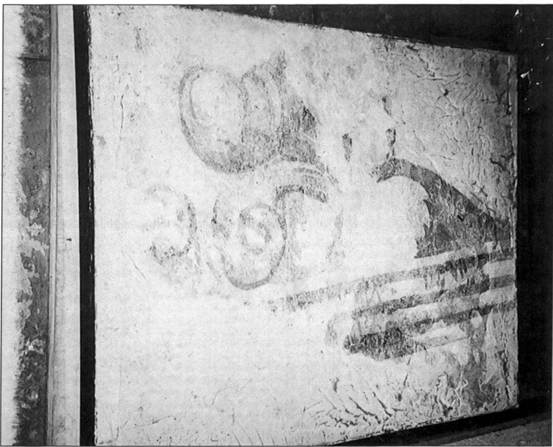
Abb. 3 Bad Säckingen, Rheinbrückstr. 8: Stuckdecke im ersten Obergeschoss.
