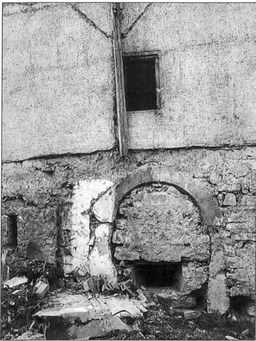
Abb. 23 Links Einfassung eines Schartenfensters am Keller; gefügt aus grob behauenen Kalksteinplatten. Blick von Westen. Rechts Keller- eingang von der Küche her; sorgfältig bearbeiteter Kalkstein, Pfosten gefast, Blick von Osten.
