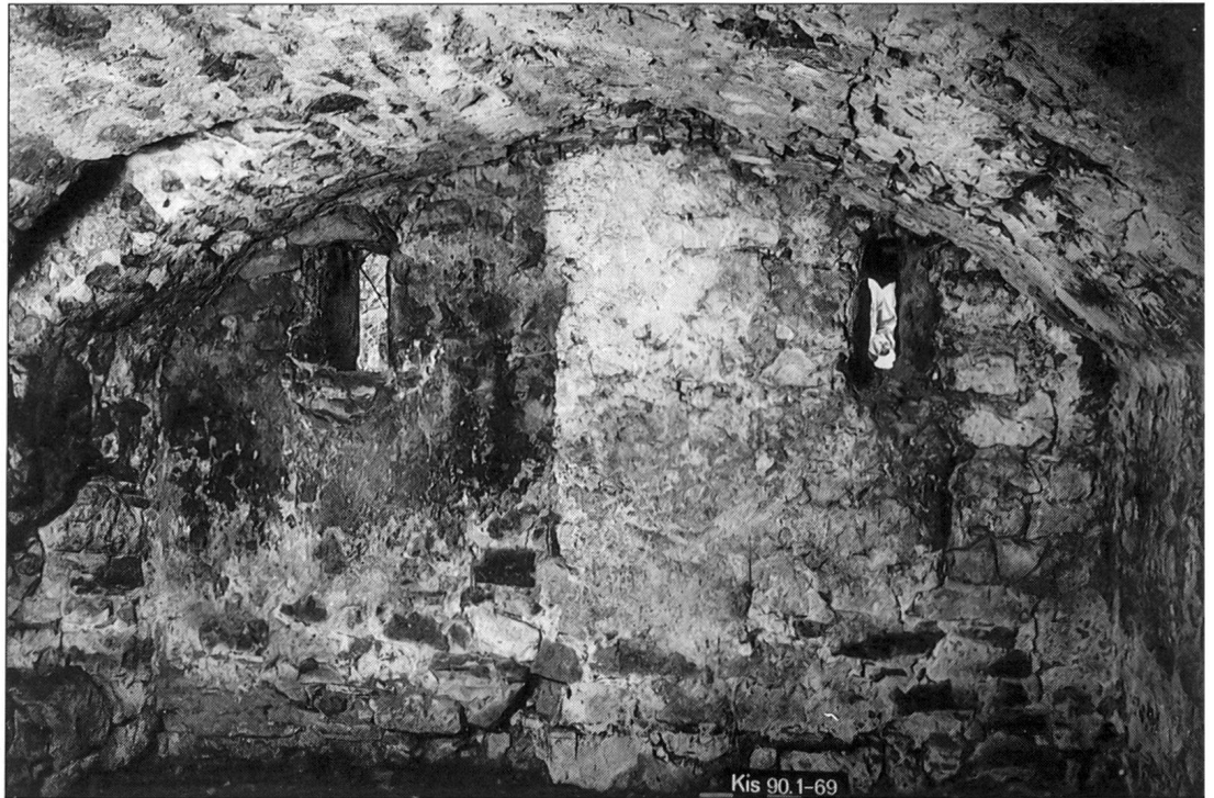
Abb. 23 Links Einfassung eines Schartenfensters am Keller; gefügt aus grob behauenen Kalksteinplatten. Blick von Westen. Rechts Keller- eingang von der Küche her; sorgfältig bearbeiteter Kalkstein, Pfosten gefast, Blick von Osten.
