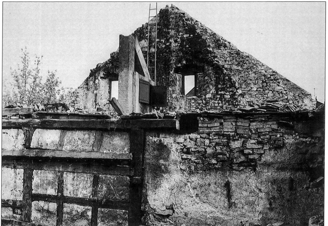
Abb. 26 Fachwerkwand von 1697/98 zwischen Wohnteil und Tenn, Abbruchsituation, Blick von Nord- westen. Im Hinter- grund Giebelmauer von 1602 (dunkles, verrusstes Mauerwerk), rechts deutlich zu sehen die Mauererweite- rung von 1697/98 (helles Mauerwerk, vgl. Abb. 11).
