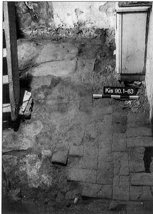
Abb. 5 Kaisten, Dorfstr. 50. Freigelegter Küchenboden von Anfang 19. Jh. im Wohnteil B.
