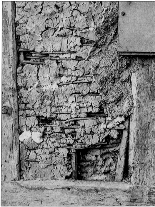
Abb. 20 Zeihen, Mitteldorf 61. Fachwerkfüllung aus Bruchsteinen im Giebelndreieck (18. Jh.).
