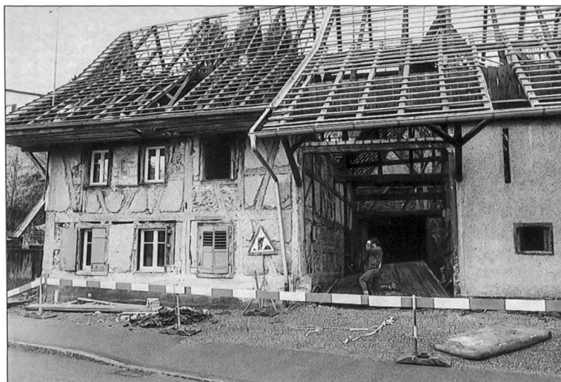
Abb. 11 Möhlin, Bahnhofstrasse 54. Abbruchsituation nach Entfernung der Dachhaut: Das zur Dokumentation freigelegte Fachwerk lässt das ursprüngliche Erscheinungsbild für kurze Zeit erahnen.
