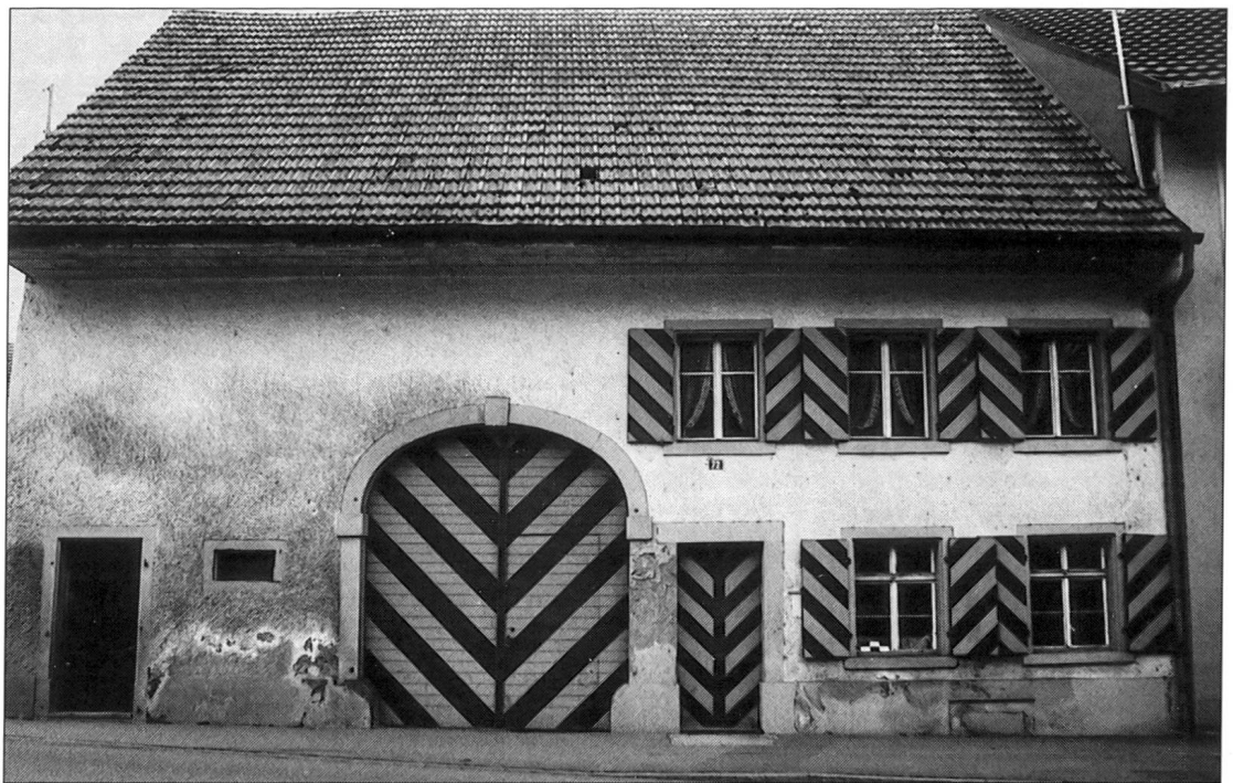
Abb. 17 Frick, Hauptstrasse 72. Das nach dem Dorfbrand von 1734 als Fachwerkbau errichtete Kleinbauernhaus (vgl. Abb. 7) erhielt im 19. Jh. eine gemauerte Fassade mit Korbbogen. Dennoch wurden beim Abbruch im Dezember 1995 nicht weniger als 35 t oder gut 70 Festmeter Bauholz abgeführt. Dies zeigt, dass auch Fachwerkbauten eine riesige Menge an Konstruktionsholz verschlangen.
