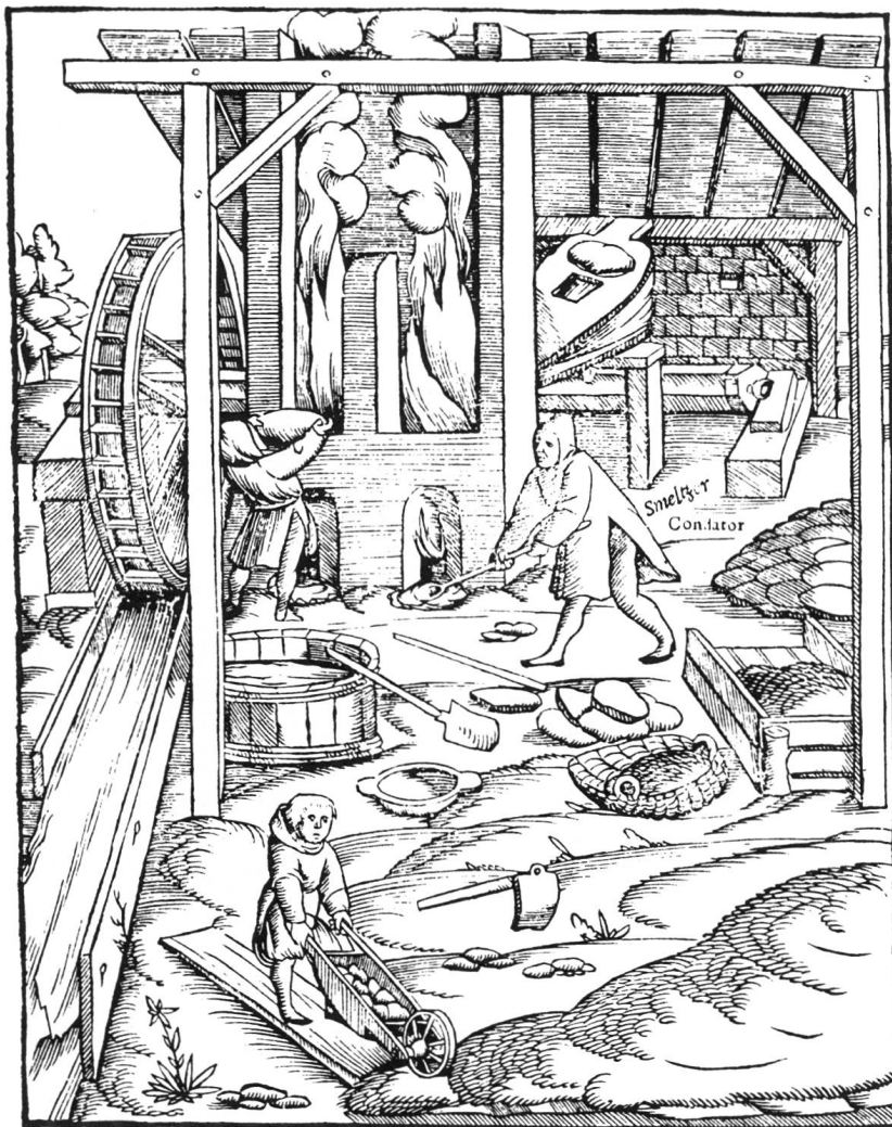
Abb. 3 Eine Bläse, wie sie Sebastian Münster in seiner Kosmographie von 1550 dargestellt hat. Hinter dem Blasofen ist deutlich der vom Wasserrad angetriebene Blasebalg zu erkennen.
