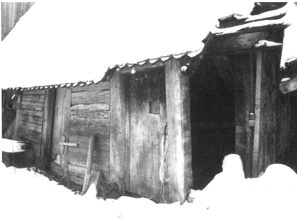
Abb. 14: Ständerwand an der Nordseite des Westhauses mit liegenden Kanthölzern als Wandfüllung. Rechts oben ist die Wandpfette zu sehen, auf der die dünnen Enden der Originalrafen ruhen.
