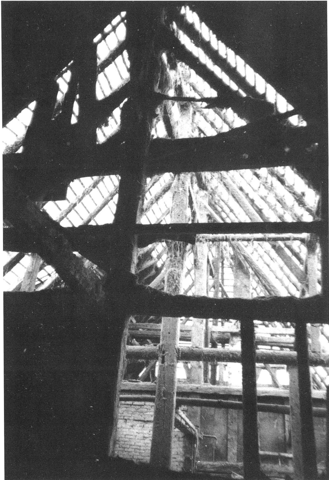
Abb. 16: Blick von der Heubühne des Osthauses Richtung Westhaus durch die «Säulenhalle» der Firstständer. (Foto: Alfons Henzmann)
