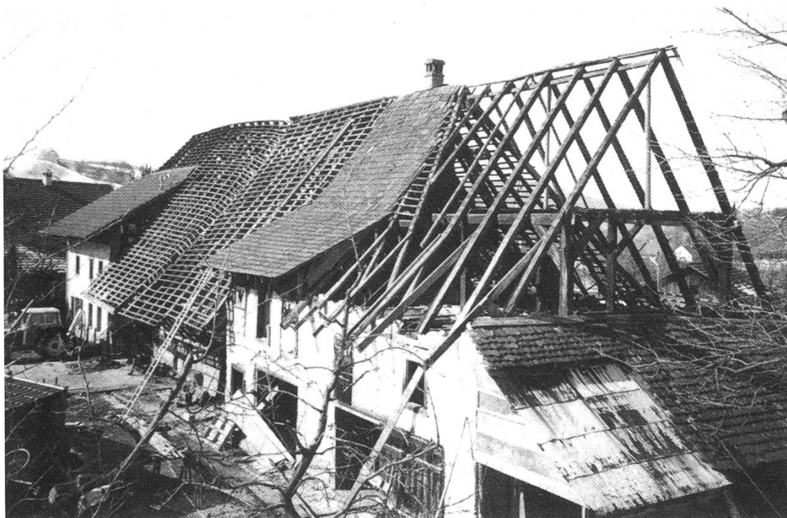
Abb. 5: Ansicht von Südosten während der Abbruchphase Anfang 1987. Rechts das Osthaus mit freigelegter Sparrenkonstruktion auf stehendem Dachstuhl. Westlich (also links) daran anschliessend der ursprüngliche Ständerbau mit Walmdach. (Foto: Alfons Henzmann)
