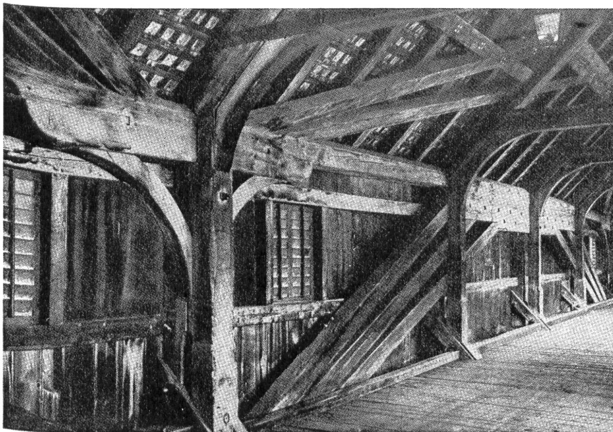
Brücke Rheinau 1804: Durchblick mit Tragkonstruktion.
