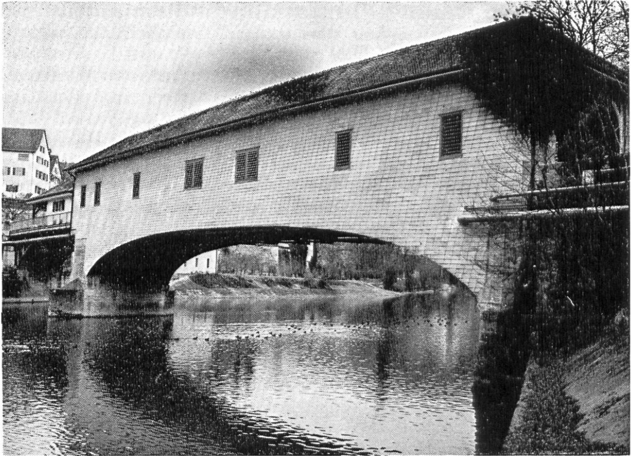
Limmatbrücke Wettingen 1818, mit Schindeln verkleidet.
