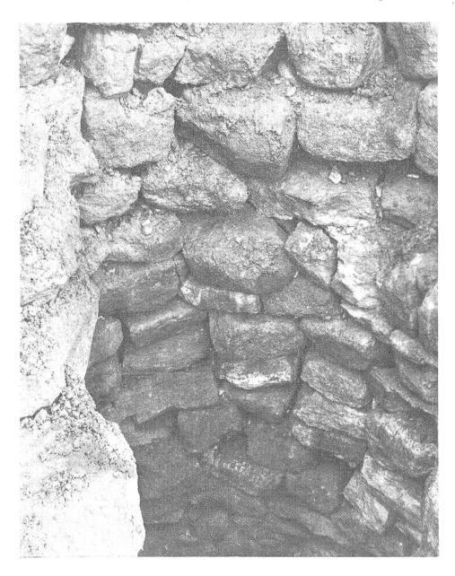
von Breisach-Hochstetten<sup>5</sup>. Während die Breisacher Brunnen quadratischen Querschnitt zeigten, waren die Rheinfelder Schächte sämtlich rund. Der Durchmesser betrug 0,80 bis 1 Meter. Das Trockenmauerwerk bestand aus Bruchsteinen (Sandsteine und Muschelkalk) und geeigneten Rheinwacken.
