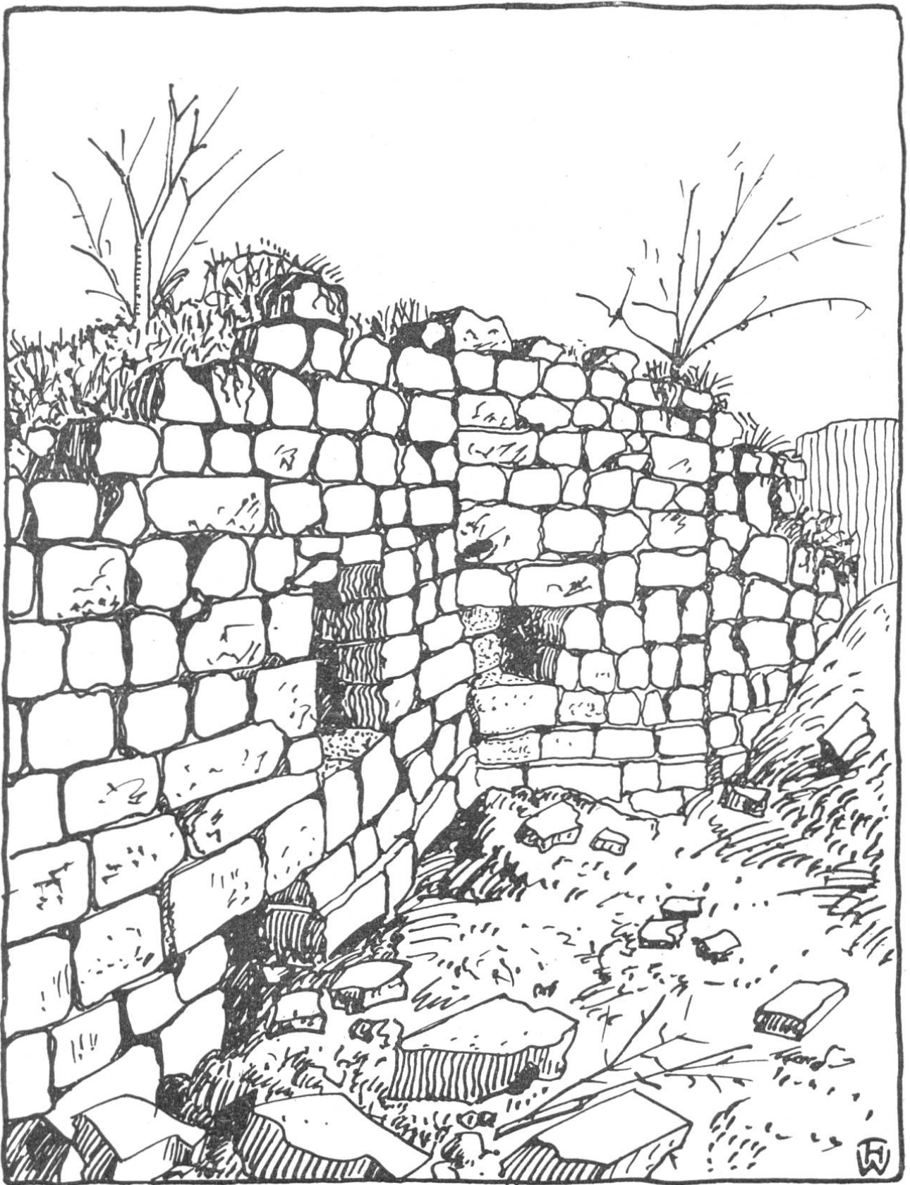
Abb. 2. — Burg Kaisten. Nordwange der Südmauer des nördlichen Raumes. (Man beachte die beiden Fugen im Mauerwerk; s. S. 68!)
