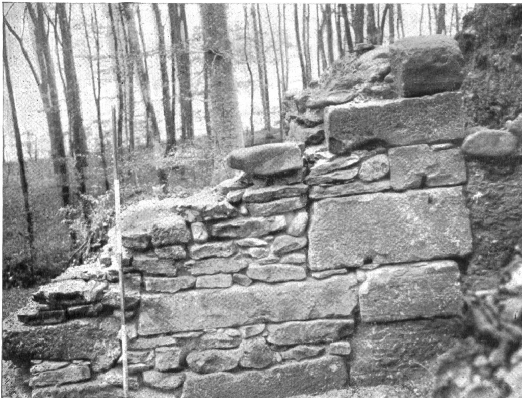
Quader in der nördl. Außenseite des Westturmes
