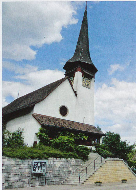
Pfarrkirche in Röthenbach im Emmental.
