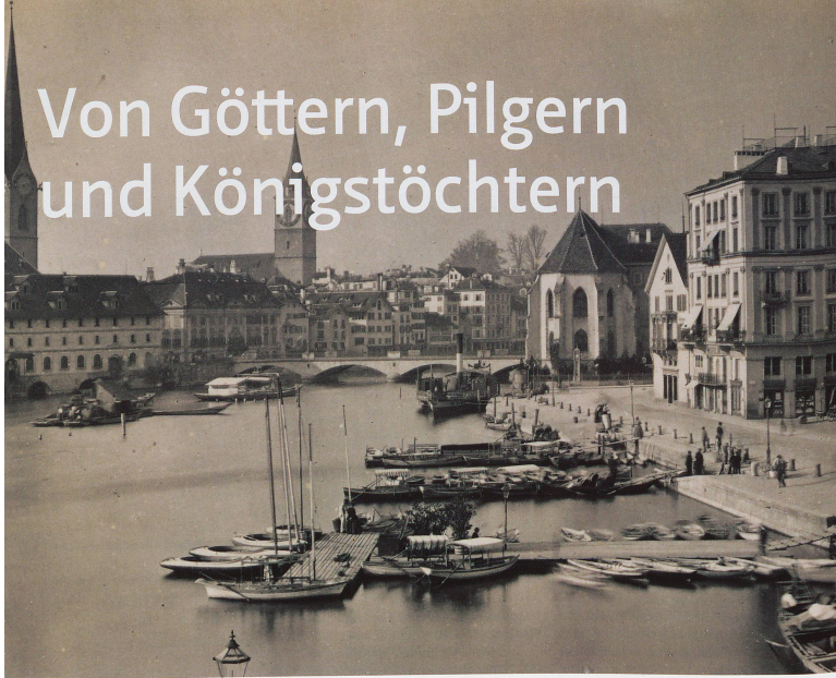
Der Kraftort Zürichs mit den vier Kirchen Grossmünster, Wasserkirche, St. Peter Hofstatt und Fraumünster, die über Jahrhunderte Pilger angezogen
