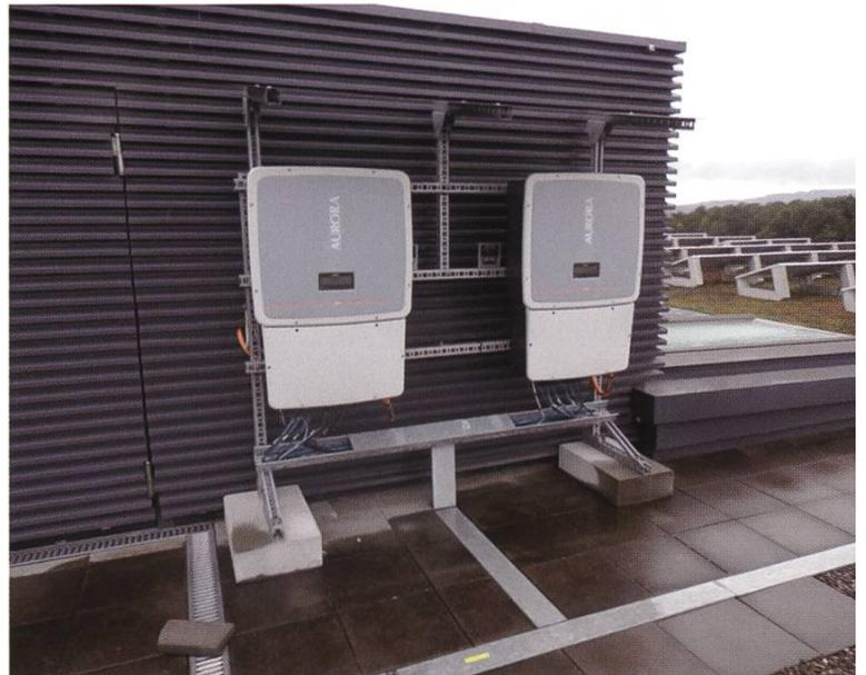
Die ruhige Atmosphäre wird nur durch das monotone Summen der zwei Wechselrichter gestört. Um den Strom der Solarzellen ins Stromnetz einzuspeisen, muss dieser zunächst von Gleichstrom in Wechselstrom umgewandelt werden. Von dort wandert er weiter zu der Verteileranlage neben der höhenverstellbaren Treppe und sucht sich anschliessend seinen Weg durch das ETH-Stromnetz.
