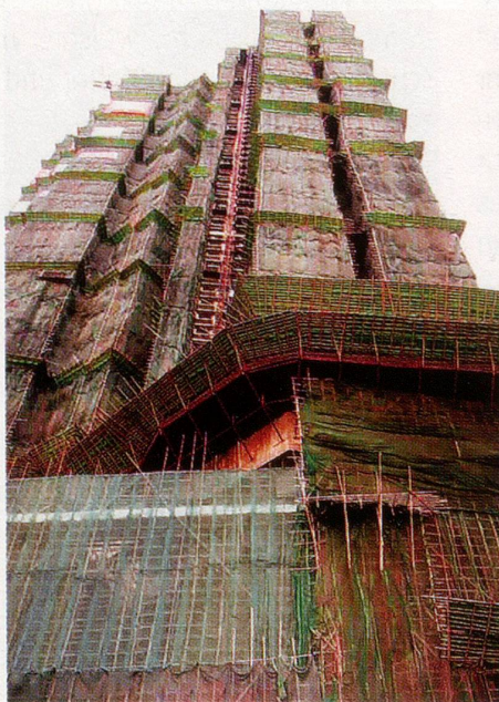
Im Hochbau auch heute noch unverzichtbar: Bambusgerüste.
