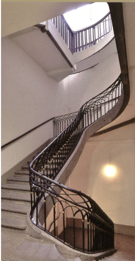
LE GRAND ESCALIER, VU DU PALIER DU PREMIER ÉTAGE AVEC LA RAMPE D'APPUI ATTRIBUABLE AU SERRURIER BRUNO FLEURY
