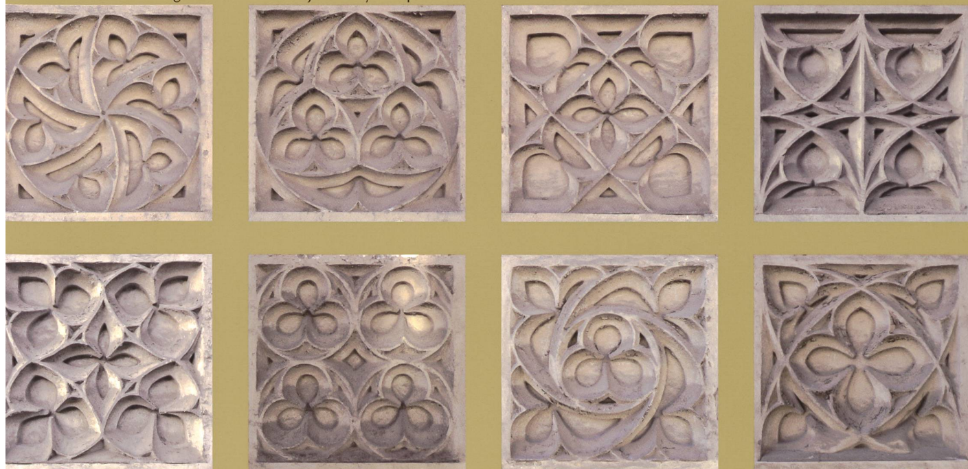
LES REMPLAGES AVEUGLES GOTHIQUE FLAMBOYANT, ENTRE 1404-07, UNE DÉMONSTRATION DE GÉOMÉTRIE ET DE TAILLE DE LA PIERRE
