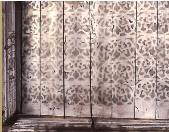
DÉTAIL DU PLAFOND DE MADRIERS JOINTIFS DE LA CHAMBRE AU TRIPLET, POSÉ EN 1518, AVEC DÉCOR DE MAURESQUES VERT SUR FOND BLANC, APRÈS 1605
