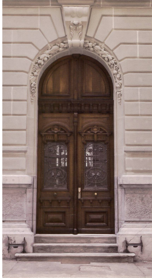
PORTE D'ENTRÉE SUR LA FACÈDE EST, MENUISERIE ÉCLECTIQUE ET FERRONNERIE ART NOUVEAU, ATTRIBUABLE AUX ATELIERS HERTLING
