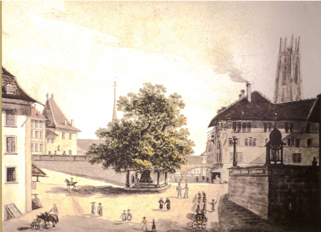
LE TILLEUL VU DU PETIT-PARADIS, AVEC, À L'ARRIÈRE-PLAN, L'ANCIENNE MAISON D'ALT, L'AQUEDUC ET LE BLETZ. SUR LE MUR DE SOUTÈNEMENT, À DROITE, SE DRESSENT LE PILORI OU TOURNIQUET – CAGE DE BOIS PIVOTANTE DONT C'EST L'UNE DES REPRÉSENTATIONS LES PLUS PRÉCISES –, ET LE PILIER DU CARCAN À COLLIER DE FER. AQUARELLE ANONYME, VERS 1830-1835 (MAHF 2000-016)
