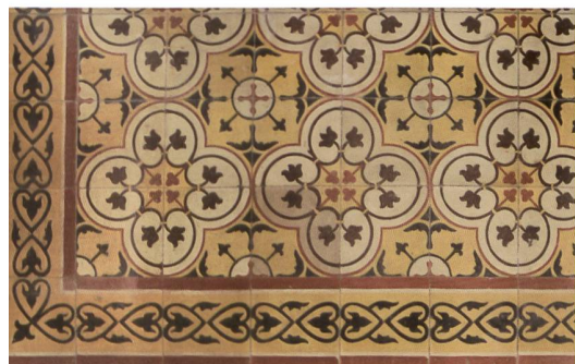
CARRELAGE EN CARREAUX DE CIMENT SUR LES PALIERS DE LA CAGE D'ESCALIER, 1912
