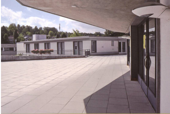
LE PARVIS DE L'ÉGLISE ET DANS LA PERSPECTIVE DE L'AUVENT EN BÉTON ARMÉ COUVRANT LE SAS D'ENTRÉE, LE 3 e NIVEAU DU BÂTIMENT PAROISSIAL TERMINÉ PAR LA CURE AU SUD
