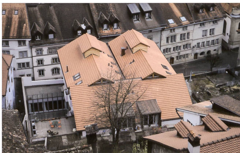
DANS LE PAYSAGE DES TOITURES DE LA NEUVEVILLE, LES TOITS RECONSTRUITS DANS LEUR VOLUMÉTRIE D'ORIGINE ET SUR LA GAUCHE, LA COUR AMÉNAGÉE SUR LA TERRASSE DE LA CAVE À FROMAGES DE 1958
