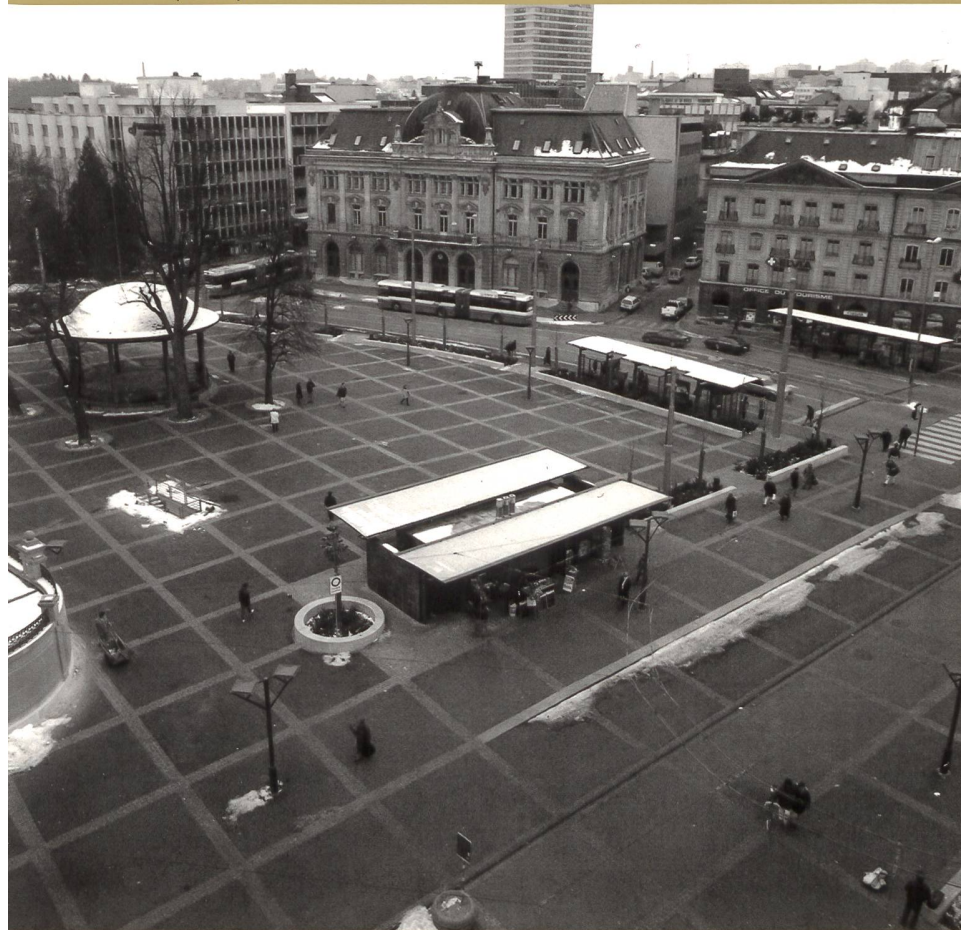
LE KIOSQUE À MUSIQUE ET SES TILLEULS D'ORIGINE, AU CENTRE DU JEU DE TRAME DE LA PLACE GEORGES-PYTHON, RÉAMÉNAGÉE EN 1991-1993 PAR L'ARCHITECTE MICHEL WAEBER (YVES EIGENMANN)
