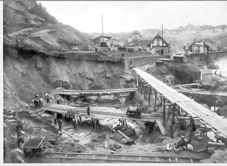
Terrassements de l'usine, février ou mars 1909 (BCUF, Fonds Salvisberg)
