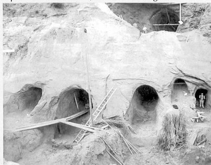
Percement des tunnels des conduites sous pression, septembre 1909 (BCUF, Fonds Salvisberg)
