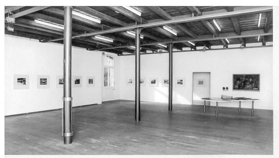
L'ancien atelier de cartonnage au premier étage, converti en salle d'exposition de FRI-ART, avec fenêtres obturées par une paroi, file de colonnes en fonte et poutres apparentes
