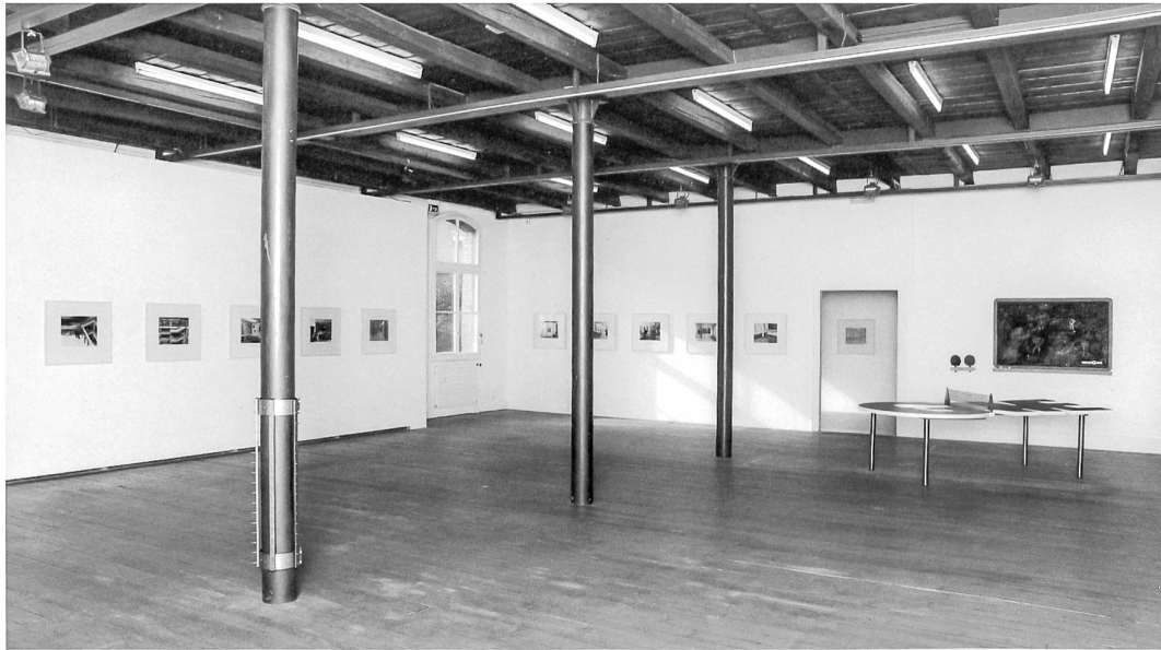
L'ancien atelier de cartonnage au premier étage, converti en salle d'exposition de FRI-ART, avec fenêtres obturées par une paroi, file de colonnes en fonte et poutres apparentes
