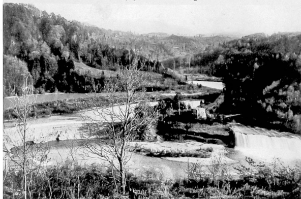
Le barrage et le déversoir de trop-plein, état d'origine, en 1901
