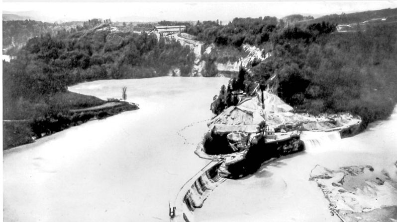
Le barrage et le « lac de Fribourg », avec la plaie encore béante du tunnel du câble téléodynamique et, sur l'horizon, la grande scierie
