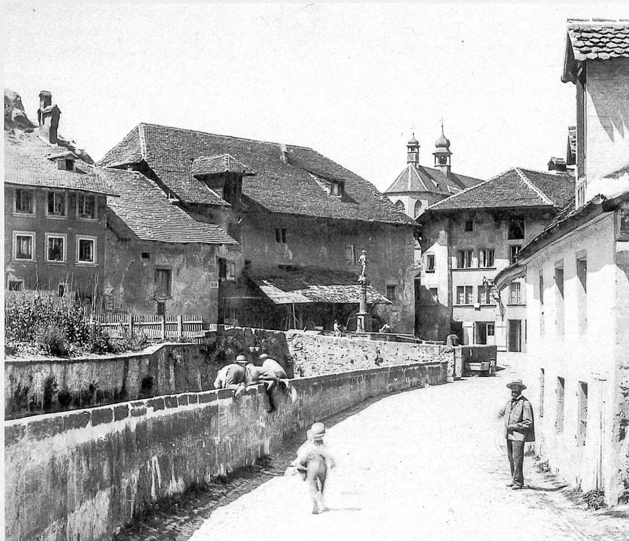
Vue de la porte du Gottéron, la maison Mooses et sa grange-écurie dans les années 1880-1890
