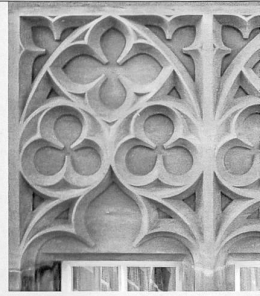
Arc en accolade et en tiers-point,
