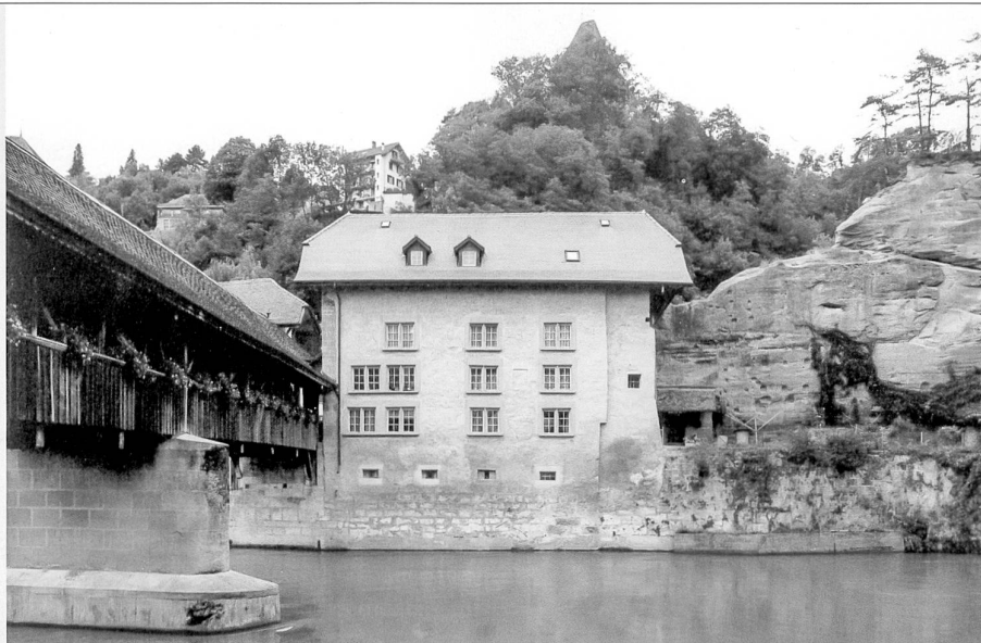
Au débouché du pont de Berne, la façade du XVII e siècle dressée sur son socle de tuf formant digue
