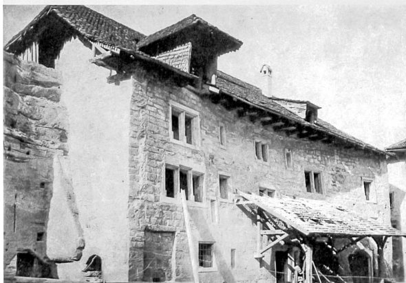
La façade sur rue, en cours de travaux, en 1923 (AFMH)
