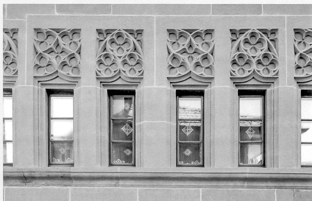
Détail de la série des quinze remplages aveugles du 1 er étage, avec le rythme ternaire des baies, croisant la répétition de deux motifs allégeant la masse murale
