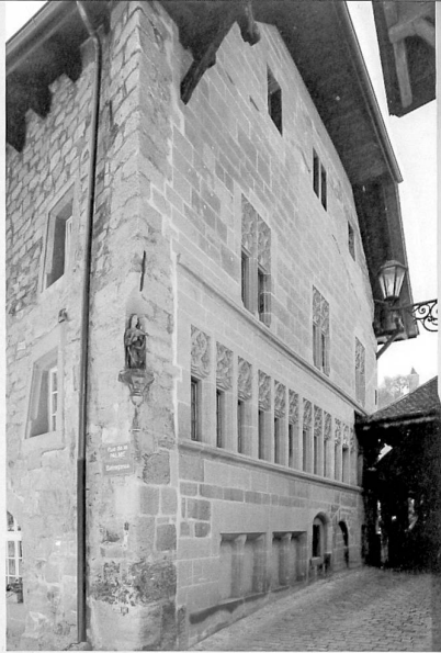
Autrefois coincée entre la porte de la Undergasse et l'entrée du pont, l'ancienne façade d'entrée
