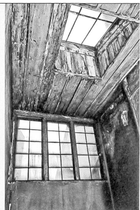
Le puit de lumière de 1736-1740, état en 1989
