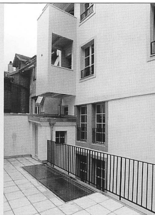
La façade la maison Gendre, après restauration
