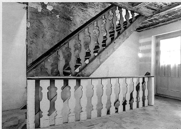
Rue de la Neuveville 17, la cage d'escalier éclairée par la façade arrière, 1769-1770, avec rampes à faux balustres chantournés, état pendant les travaux, en 2002
