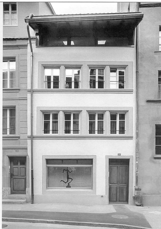
La façade sur rue de la maison n° 21, fin du XIV e siècle ou début du XV e siècle
