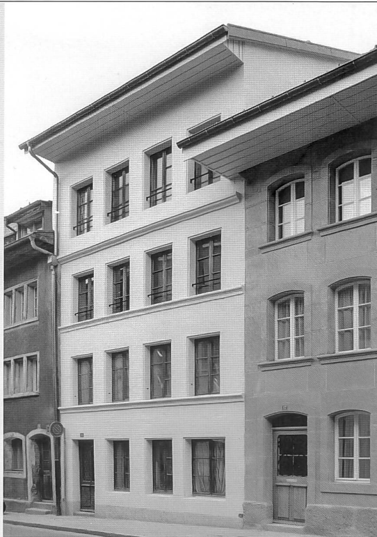
La façade sur rue de la maison n° 15, fin du XVIII e s. ou début du XIX e s., surélevée d'un étage en 1902
