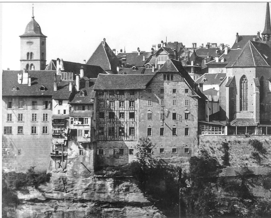
La façade en pans de bois du grenier de 1475, reconstruite en 1732 et la façade en molasse du grenier de 1527, reconstruite à la fin du XVIII e siècle, état avant 1929
