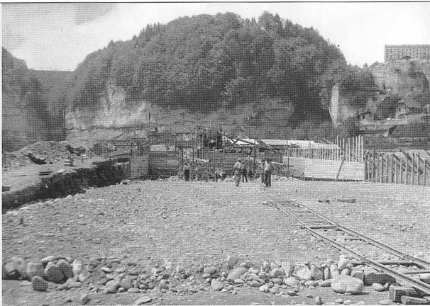
Les bains en construction (Photo Kern Lausanne, ASBC)
