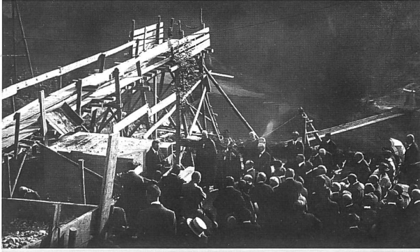
Pose et bénédiction de la 1 re pierre par Mgr Besson, le 11 septembre 1920. On distingue en contrebas la passerelle de Marly (1918), dont il ne reste aujourd'hui qu'un pylône (Paul Savigny, ASBC, carte postale)
