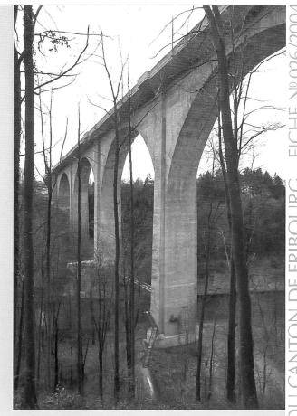
Le pont de Pérolles, à la hauteur du pylône de l'ancienne passerelle de Marly, avec au premier plan la pile la plus élevée, d'une septantaine de mètres, la seule qui repose dans le lit de la Sarine
