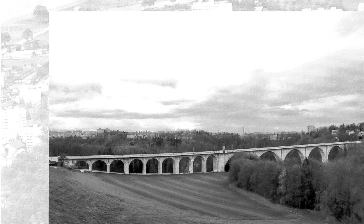
Ouvrage en béton réalisé en 1920-1922 par l'entreprise Züblin & Cie de Zurich et le charpentier grison Richard Coray, d'après les plans et sous la direction des ingénieurs Jules Jaeger et Armin Lusser, de Fribourg, tablier refait et élargi en 1995-1997
