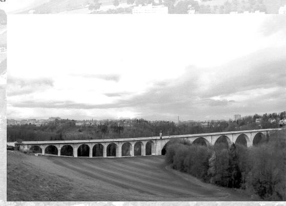
Ouvrage en béton réalisé en 1920-1922 par l'entreprise Züblin & Cie de Zurich et le charpentier grison Richard Coray, d'après les plans et sous la direction des ingénieurs Jules Jaeger et Armin Lusser, de Fribourg, tablier refait et élargi en 1995-1997
