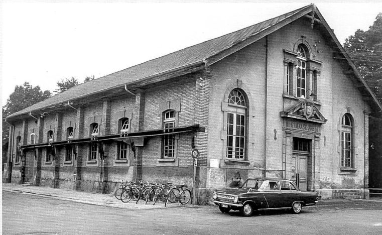
La halle de gymnastique, construite en 1894-1895 sur les plans de l'architecte Adolphe Fraisse, avant sa démolition en 1974
