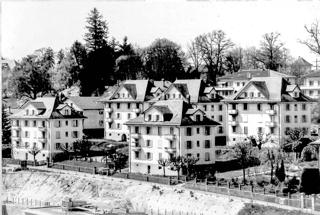
Cité-jardin construite par la Société Coopérative Immobilière des Maisons Ouvrières «La Fraternelle», sur les plans des bureaux Diener & Schaller et Cuony & Devolz, 1924-1925
