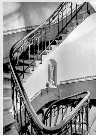
L'escalier de l'appartement des Pères, dans le pavillon sud, en 1936, avec sa rampe et son décor d'origine, Lincresta et frise florale peinte au pochoir (BCU Archives Médiacentre 022/18, Fonds Benedikt Rast)
