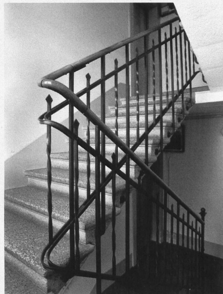
Cage d'escalier avec rampe réalisée en 1924 par le serrurier Ernst Schwab, de Fribourg, sur les plans de Schaller & Diener, 1924
