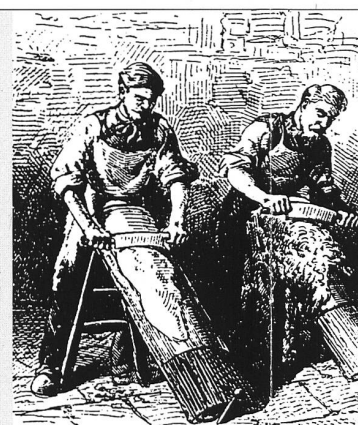
Dépoilage des peaux au moyen de couteaux à ébourrer (Nouveau Larousse Illustré, 1907)
