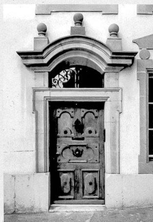
Porte de 1906 avec ferrures de remploi des années 1700, chambranle daté 1703 à l'intrados de la fenêtre en dessus de la porte
