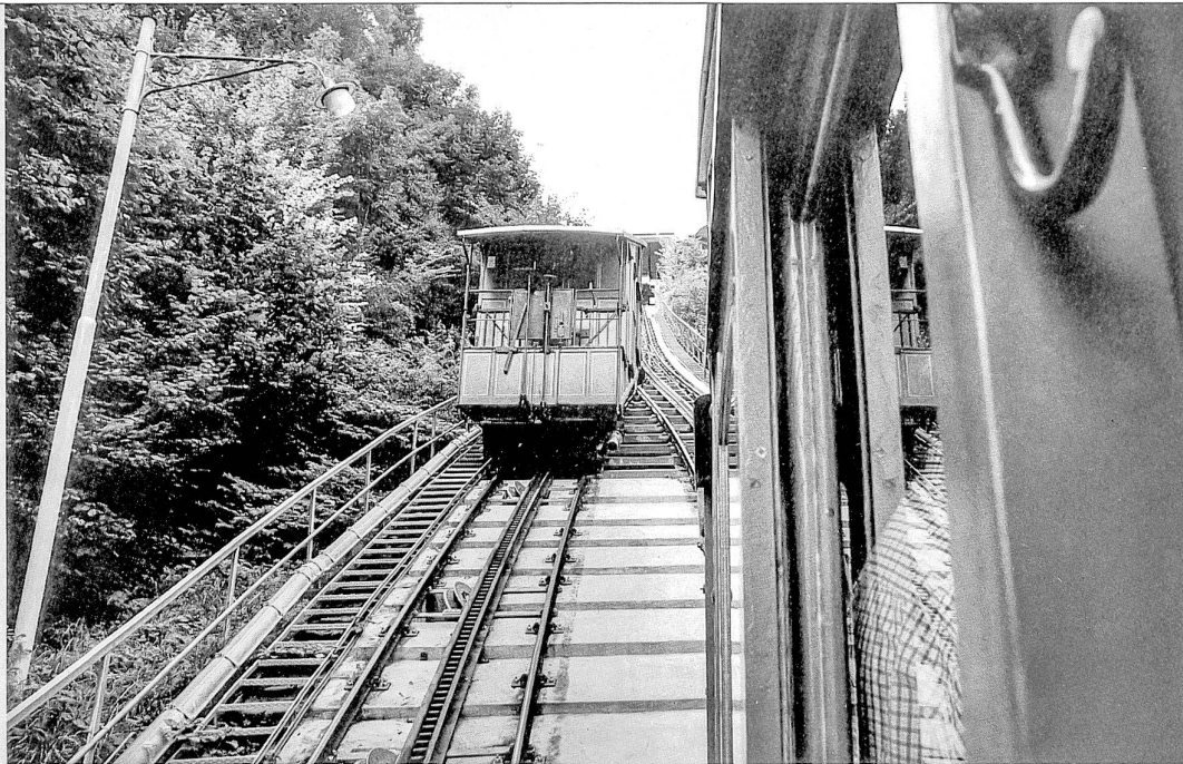
Croisement terminé: la voiture lestée d'eaux usées file à 4 km/h vers la station inférieure entraînant par contrepois le véhicule opposé
