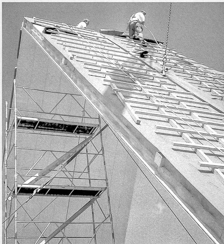
La reconstruction de la toiture du Werkhof en 2001 a constitué un défi technologique, les dalles Wellsteg n'ayant encore jamais été mises en œuvre sur une telle surface (ASBC, Jacques Vial)
