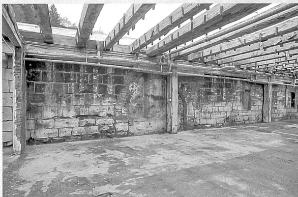
La façade nord, vestige du premier Werkhof, 1416-1417, avec la porte de 1556 et la poutraison de 1824 au-dessus
