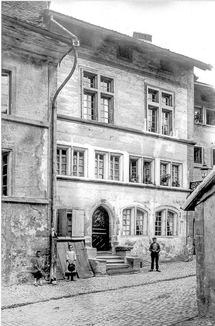
Avant sa surélévation en 1900, la maison présentait encore intacte son élévation des années 1400 avec, au 2 e étage, les grandes croisées de la fin du XVI e siècle (ASBC, Fonds Reiners)
