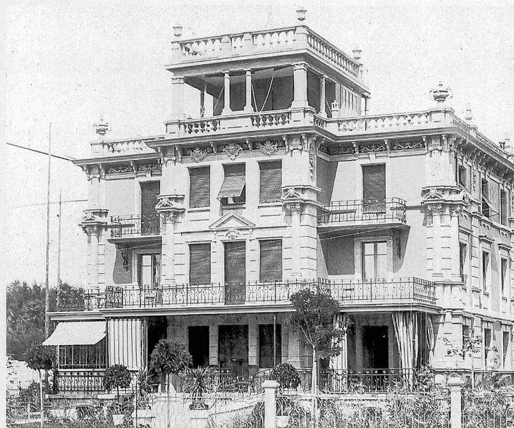
La maison achevée, en 1903 (Aeby, ASBC)
