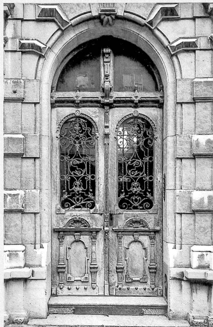
L'entrée sur le boulevard de Pérolles avec sa porte d'origine
