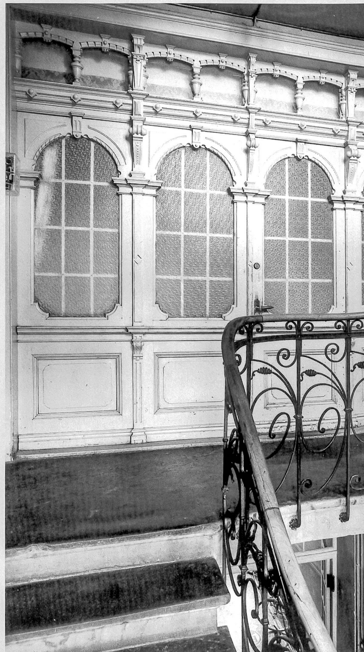
L'entrée de l'appartement du premier étage
