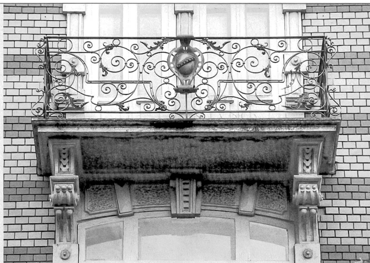
Le balcon du premier étage avec balustrade en fer forgé vraisemblablement réalisée par l'atelier Hertling
